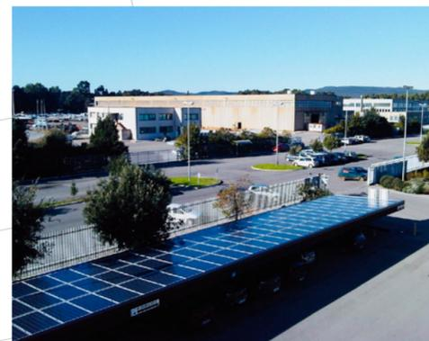
L'impianto solare fotovoltaico è realizzato su pensilina parcheggi per la ricarica di autoveicoli tramite colonnine elettriche "fast-charge". Perfettamente integrato architettonicamente, consente la ricarica in autoconsumo della flotta di veicoli elettrici aziendali. L'energia in eccedenza prodotta dall'impianto fotovoltaico viene immagazzinata in sistema di accumulo o ceduta in rete ad enel distribuzione e GSE.
